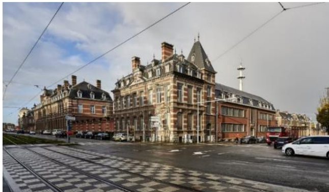
Le bâtiment actuel au coin boulevard Général Jacques / Avenue de la Couronne. © sau-msi.brussels
